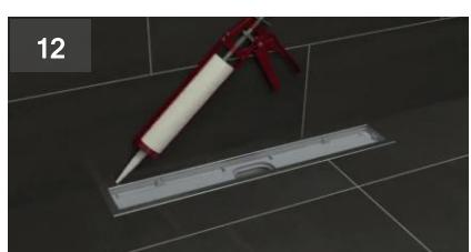
Между рамкой и напольным покрытием нанесите слой герметика (например, силикон).
