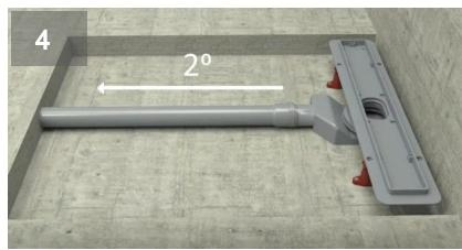
Присоедините канализационную трубу к выходу трапа с уклоном не менее 2 градусов от трапа.
