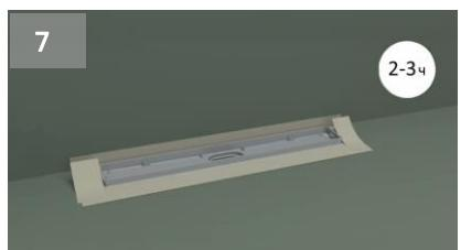
Заклейте края карьера решетки до внутреннего периметра карьера гидроизоляционной лентой MAPEI, входящей в комплект.
